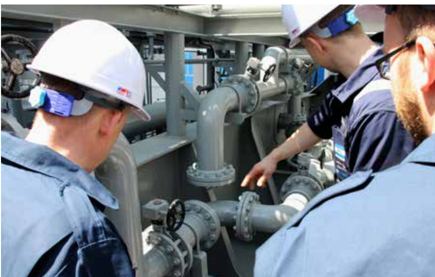
VIKTIG: Her er det koblingen mellom lagertanken og dagtanken som blir studert. Den har et swing bend som gjør at man kan pumpe metanol fra lastetanker til dagtanken.
