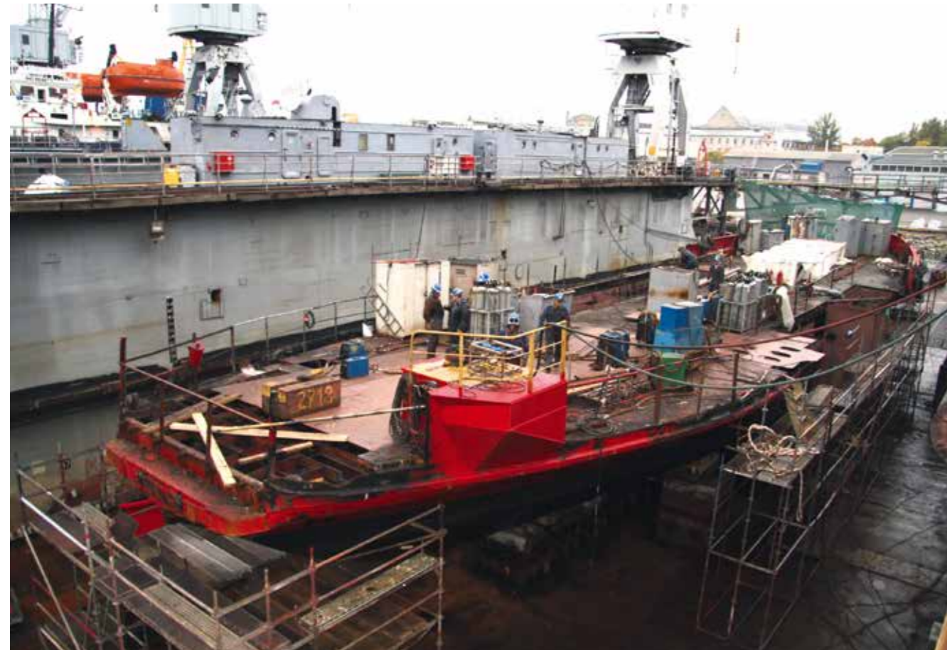
OMBYGGING: Fartøyet «Flekkerøy» ble bygd om i 2013. Her er det meste av rekkverket borte. Nytt dekk er på plass på fordekk, og ballast-tank på babord side blir bygget.
